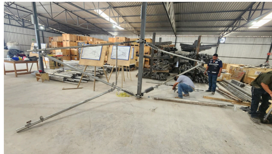
Fabricación de mensulas en almacén
