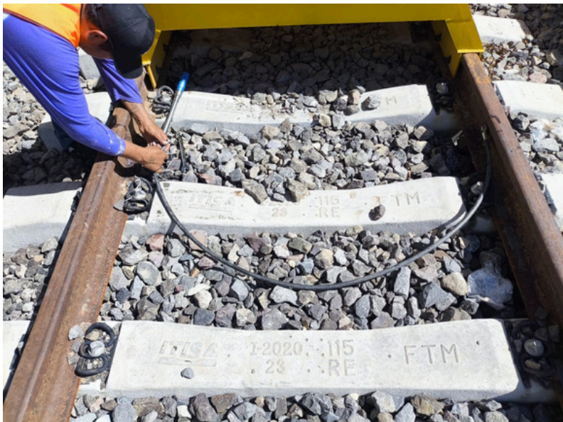
Instalación del sistema de tierras físicas
