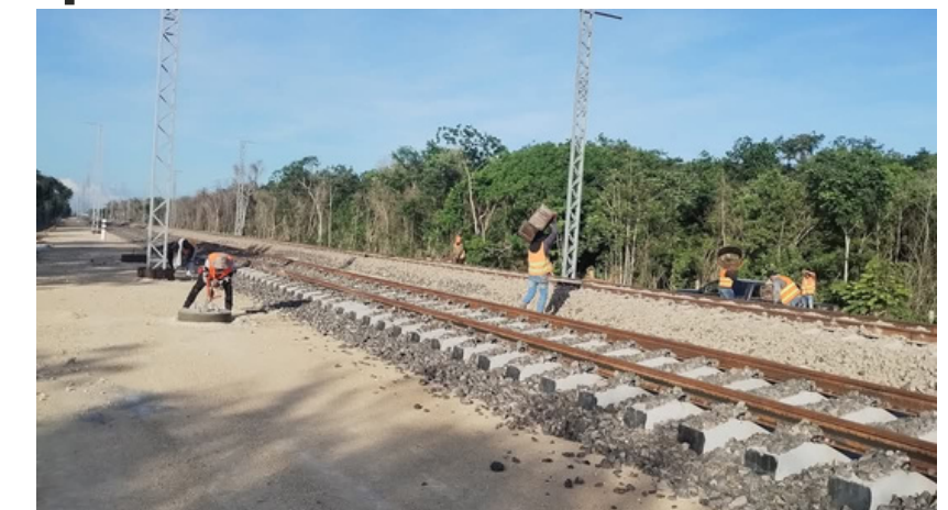
Montaje y vestido de postes
