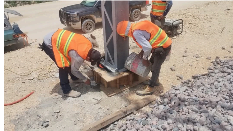
Aplicación de grout en postes
